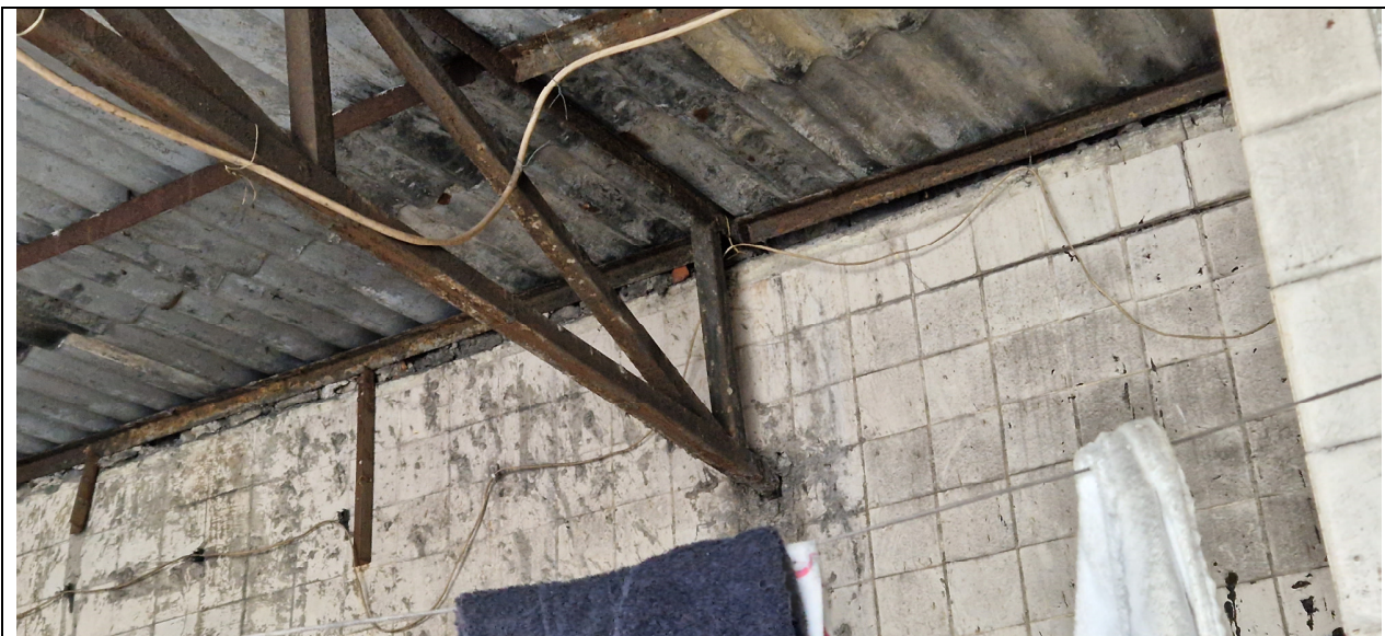
Zdjęcie 4. Widok fragmentu kratownicy wiaty, z widoczną korozją
