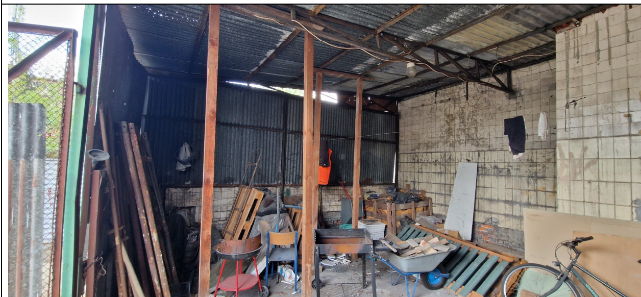
Zdjęcie 2. Widok konstrukcji wiaty z widocznymi doraźnymi podparciami płatwi
